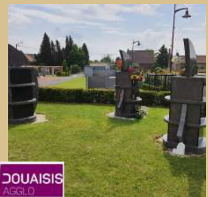
Installation de deux nouveaux columbariums (subvention de 6000 euro de Douaisis Agglo).
