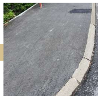
Réfection des trottoirs rue de l'abreuvoir
