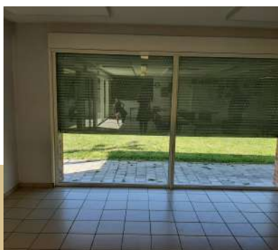
Changement des volets électriques du stade
