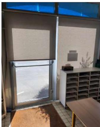
Installation de stores électriques intérieurs aux fenêtres de l'école
